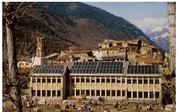
Instal·lació d'energia solar en una escola
