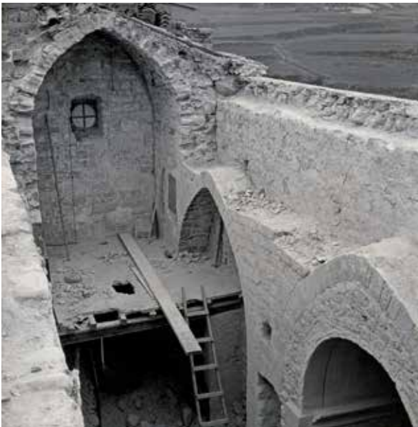
Nau de l'església durant el procés de desmuntatge de la volta, que va ser substituïda per bigues de formigó. S'hi pot veure el reguixament interior dels murs realitzat el segle XIII amb arcs formers.
