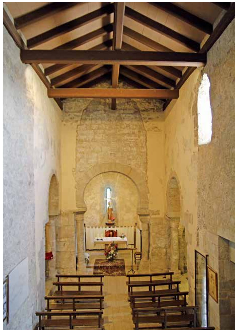
Vista de l'interior de l'església des del cor, després de la intervenció de 1959-1962, en què es van desmuntar la volta i els arcs formers del segle XIII, i es va reconstruir amb bigues de formigó l'antiga estructura de bigues de fusta de la coberta preromànica. Foto: Carme Sellés Rusiñol, 23.08.2012
