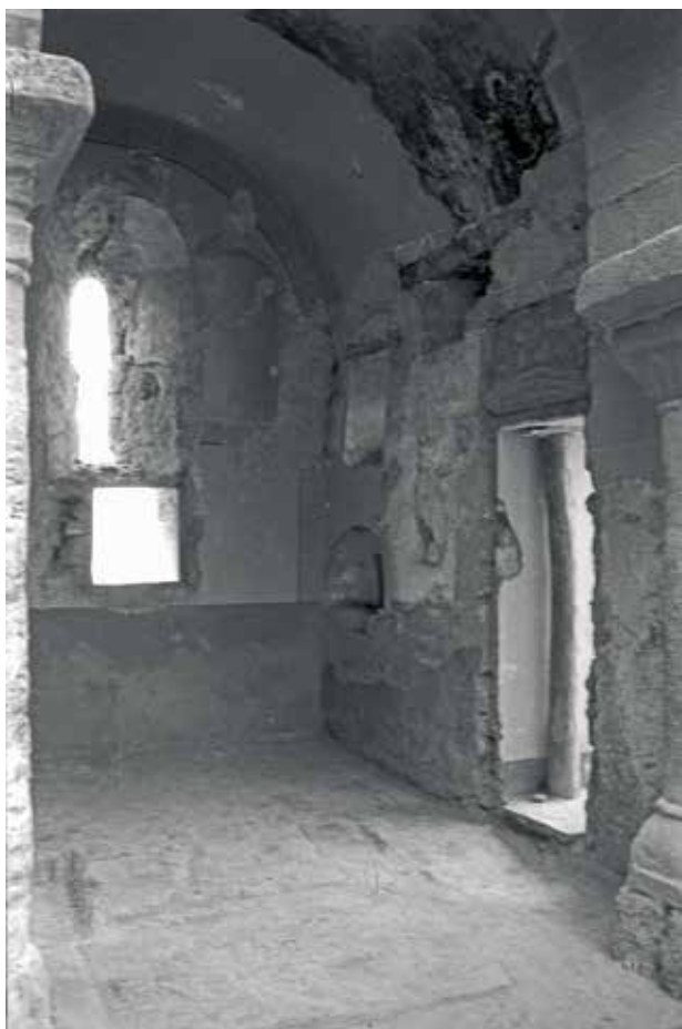
Vista de l'absis en procés d'excavació. A la dreta, la porta que comunicava el presbiteri amb la sagristia adossada a la façana de migdia en l'època moderna, que va ser desmuntada. Foto: Joan Francés Estorch, Arxiu SCCM-SPAL, c. 1960.
