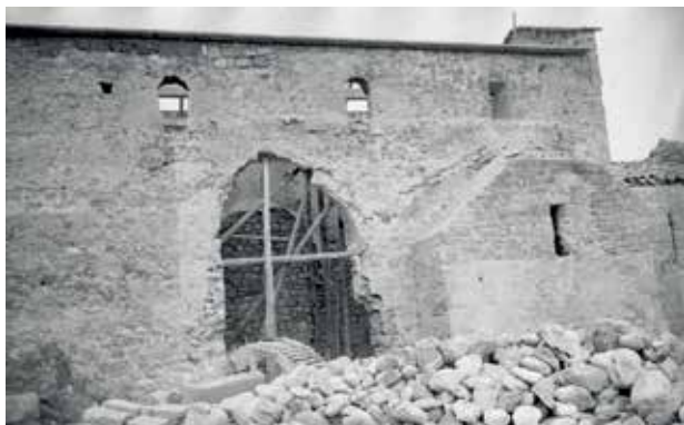
Façana sud del temple. Al centre, l'embocadura d'una capella bastida en l'època moderna després del seu desmuntatge; a la dreta, el braç meridional del transsepte durant la seva recuperació volumètrica. Foto: Joan Francés Estorch, Arxiu SCCM-SPAL, 29.11.1960
