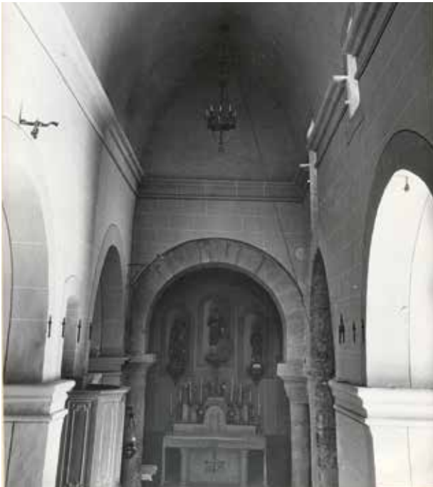
Interior de la nau abans de la restauració de 1959-1962. S'hi aprecia la volta de canó apuntada, bastida al segle XIII, els revestiments d'època barroca i l'accés a les capelles laterals i al transsepte.
