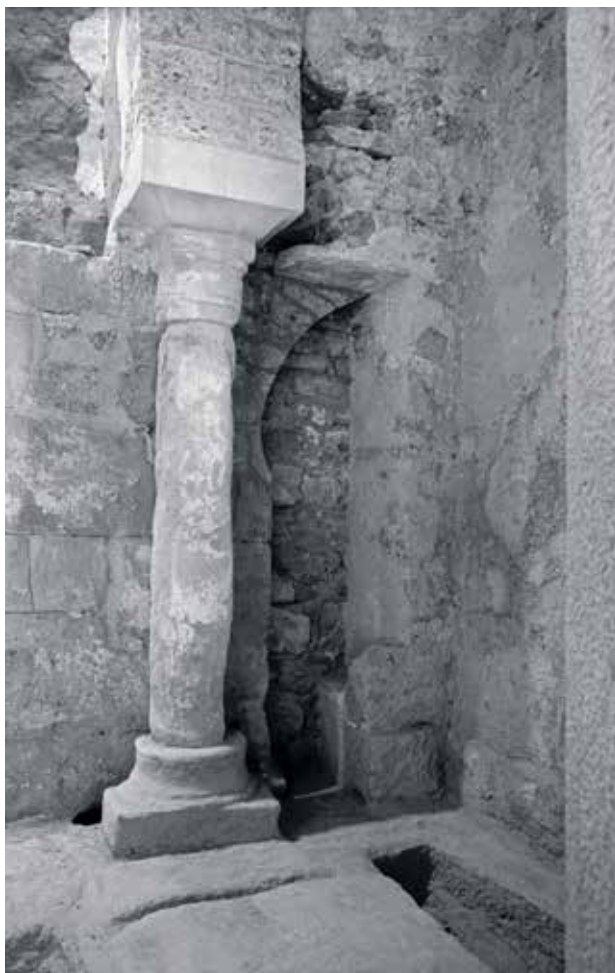
Detall del braç de migdia del transsepte una vegada desmuntat el regreuixament dels murs realitzat el segle XIII. Hom pot veure la columna ja exempta i, a la dreta, restes de l'arc de l'absidiola meridional de la primitiva església visigòtica. Foto: Joan Francés Estorch, Arxiu SCCM-SPAL, 8.03.1965
