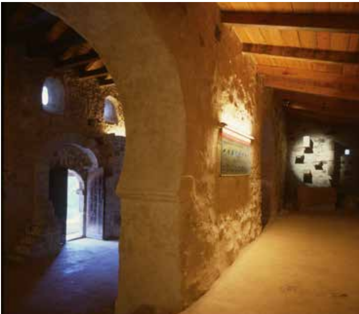
Visió de la nau central (a l'esquerra) i de la nau nord, situades a diferents cotes de nivell.
