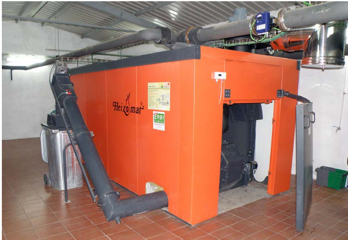
Caldera de biomassa a la xarxa de calor del centre social de la Fundació San Cebrián (Palència). (Foto: Javier Rico)
